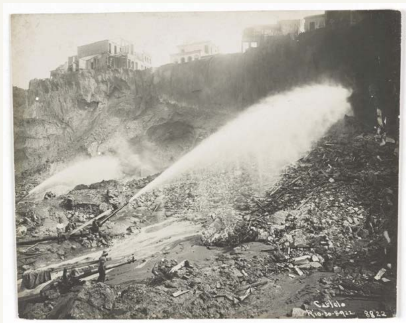
Jatos d'água são usados para remoção de terra do Morro do Castelo. Tomada do fundo da Santa Casa de Misericórdia. 1922. Fotografia de Augusto Malta. Rio de Janeiro (RJ). Acervo Instituto Moreira Salles.
