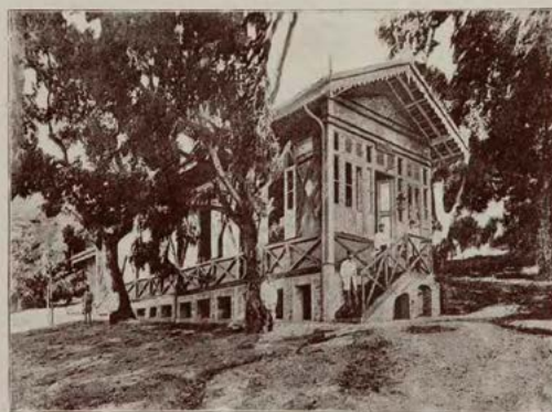
HOSPITAL S. SEBASTIÃO. Pavilhão de observação
