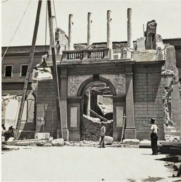
Demolição do prédio da Academia, em 1939. O frontispício foi preservado e remontado no Jardim Botânico do Rio de Janeiro. 1939. Rio de Janeiro (RJ). https://commons.wikimedia.org/wiki/File:Demoli%C3%A7%C3%A3o_da_Academia_Imperial_de_Belas_Artes_01.jpg
